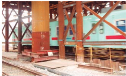
写真-3 営業線近接状況
