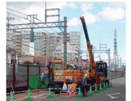
写真-1 TBH工法(MPD機)施工全景
