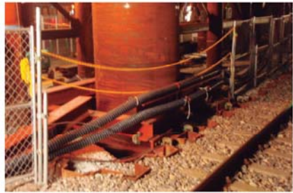
写真-2 回転圧入杭施工完了
