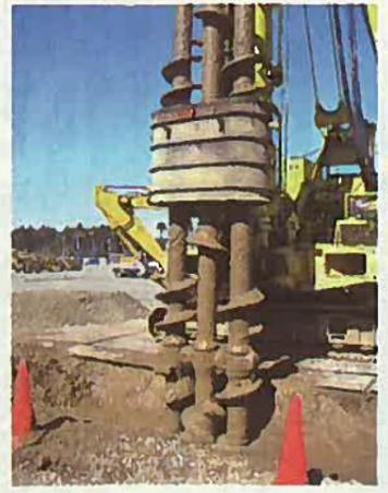
実験工事での遮水壁構築
