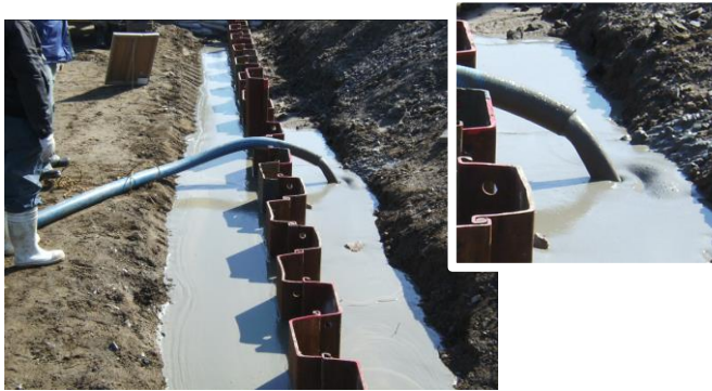
写真① シートパイル引抜き充填事例
